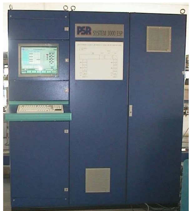
PSR940 控制系统盘面。简单区域控制及温度记录。
