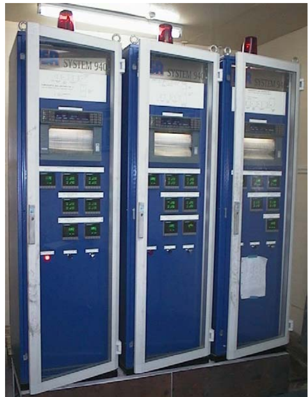
PSR940 控制系统盘面。简单区域控制及温度记录。
